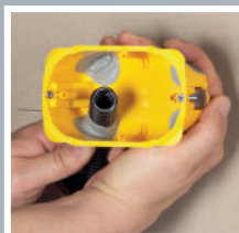
Insert the conduits
